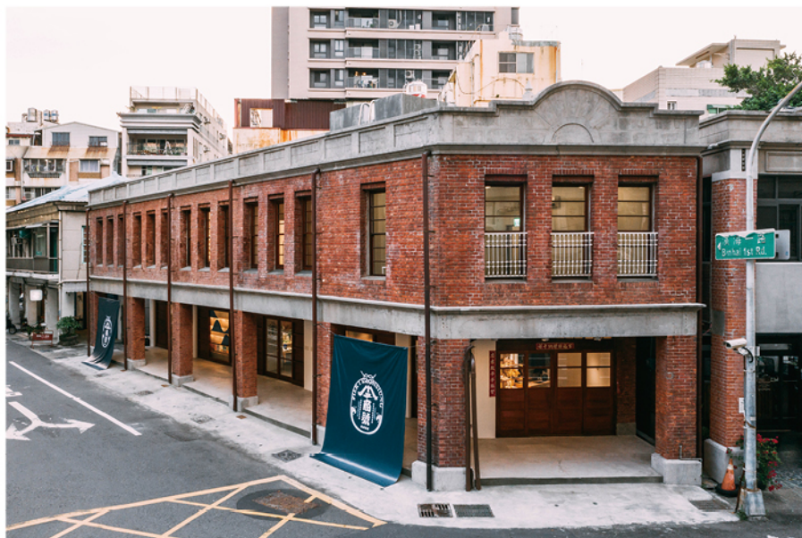
歷史建築「新濱町一丁目連棟紅磚街屋」1933年由楊家所建，為哈瑪星僅存少數昭和時期的紅磚街屋。
