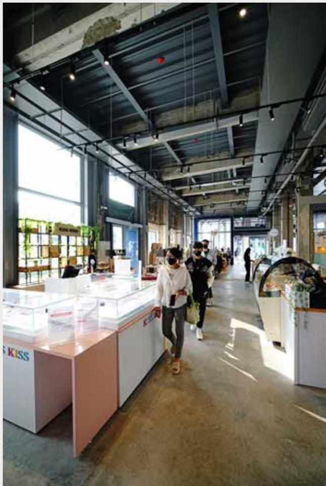
改造過程尊重歷史、新舊融合，保存舊倉庫梁柱結構，並以「風格櫥窗」為構想，磚牆改為通透的玻璃材質，讓空間更開闊。
