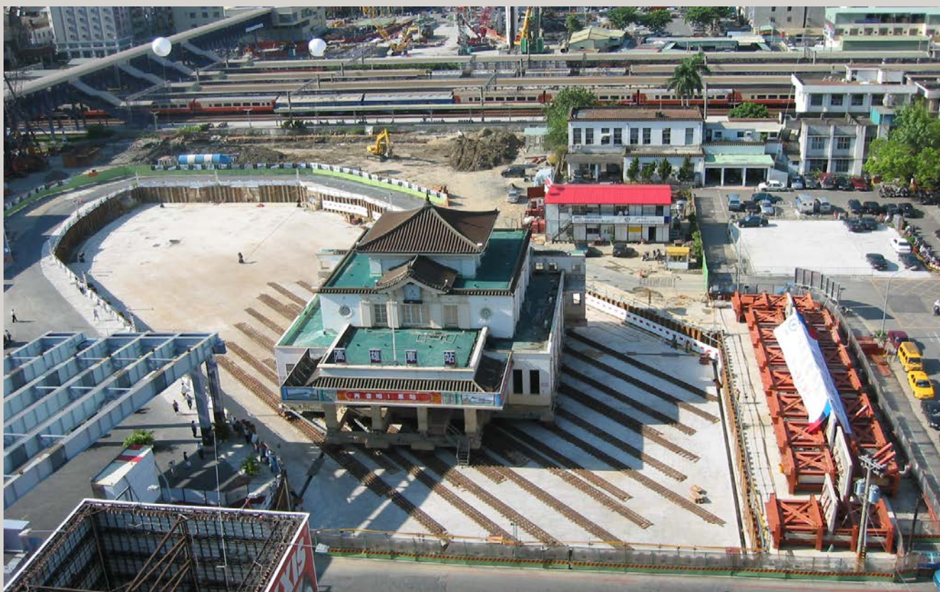
搬遷車站使用總掘工法，先以千斤頂抬高建築，再鋪設鋼軌緩慢平移。
