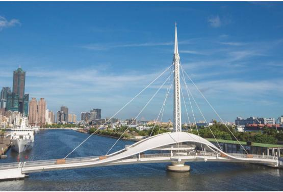
雄港で今年7月に開通した「大港 「一」橋」は、台湾港務公司により建設された、台湾初の旋回橋だ。駁二芸術特区 と蓬莱商港区をつなぎ、両エリア間で歩 行者の行き来が可能になった。旋回橋は 決まった時間に旋回して船を通らせた後、 再び元どおりの橋へと戻る。現在、高雄 の新たな観光スポットとして注目を浴びて いる。
