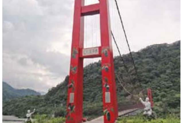
■ 索阿紀吊橋(上)與瓦阿係吊橋(下)都能通行車輛
