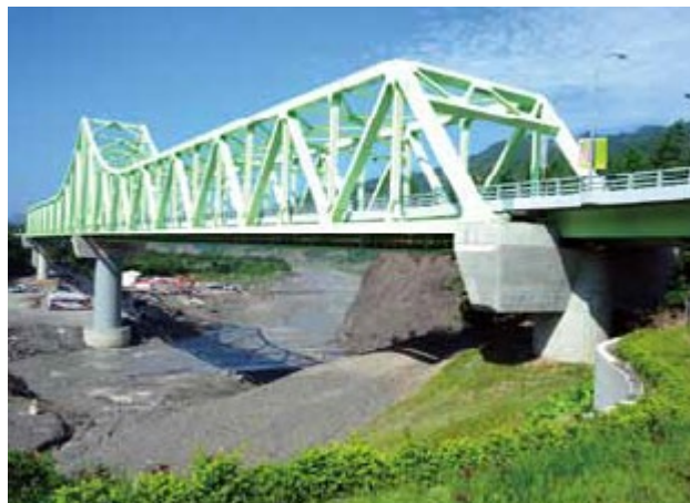
■ 新發大橋擁有美麗的鋼骨結構造型
