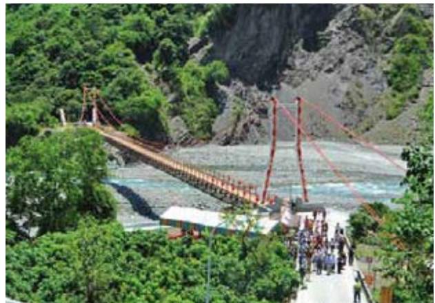
■ 達西霸樂吊橋有如原住民頭上的五彩頭飾
