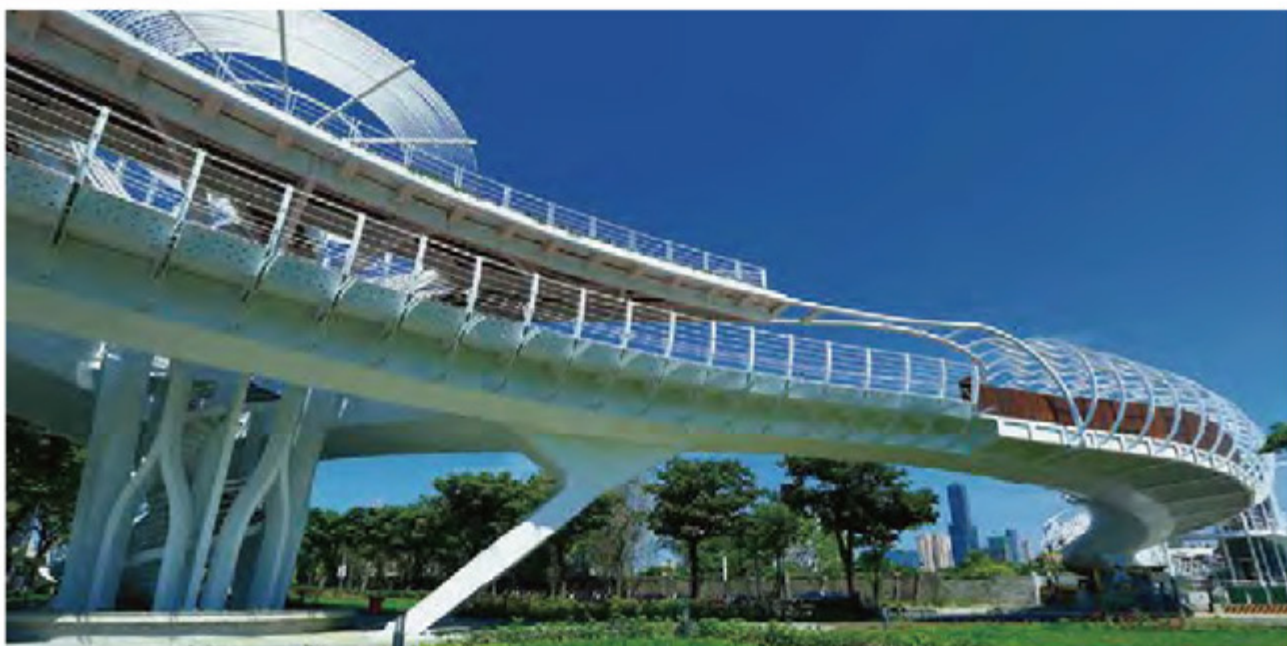
■ 前鎮之星自行車道橋完工後立即成為高雄市的新亮點
