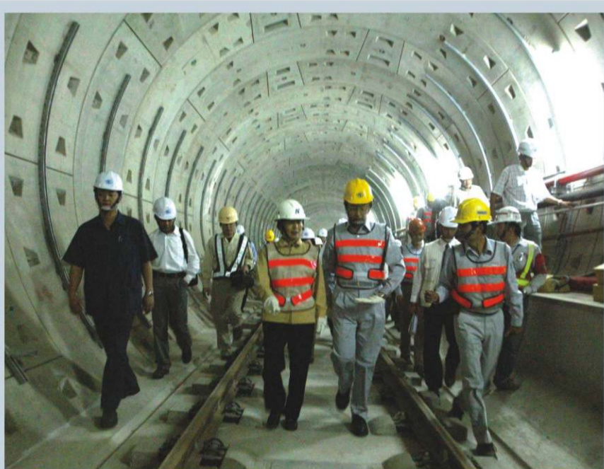
泰籍勞工朋友是讓高雄捷運工程順利進行的一大助力，高雄捷運預定於今年10月底達成紅線R3-R8通車目標。(照片提供/高雄捷運股份有限公司)
