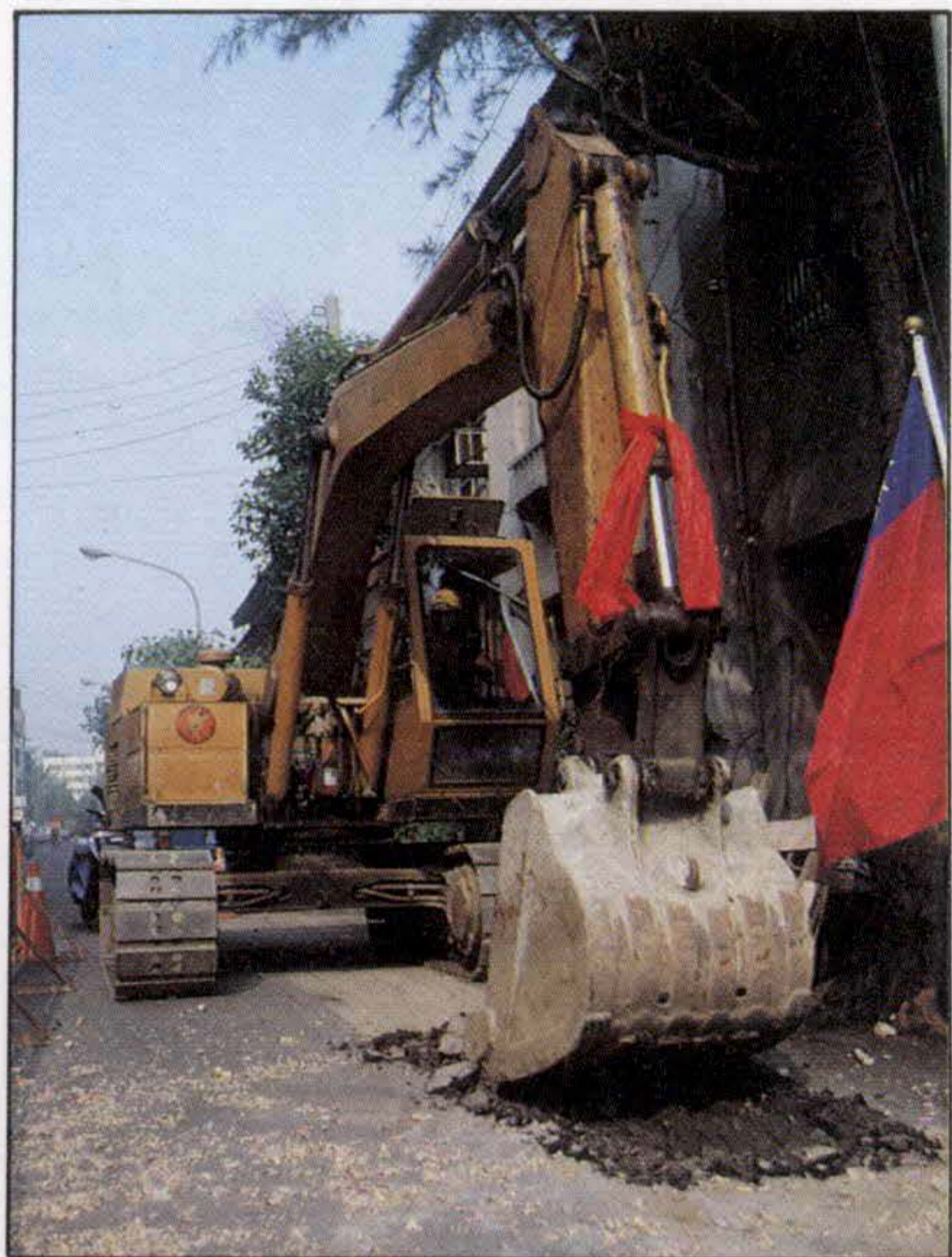
挖土機正在施工，預計工程兩年內完成。
