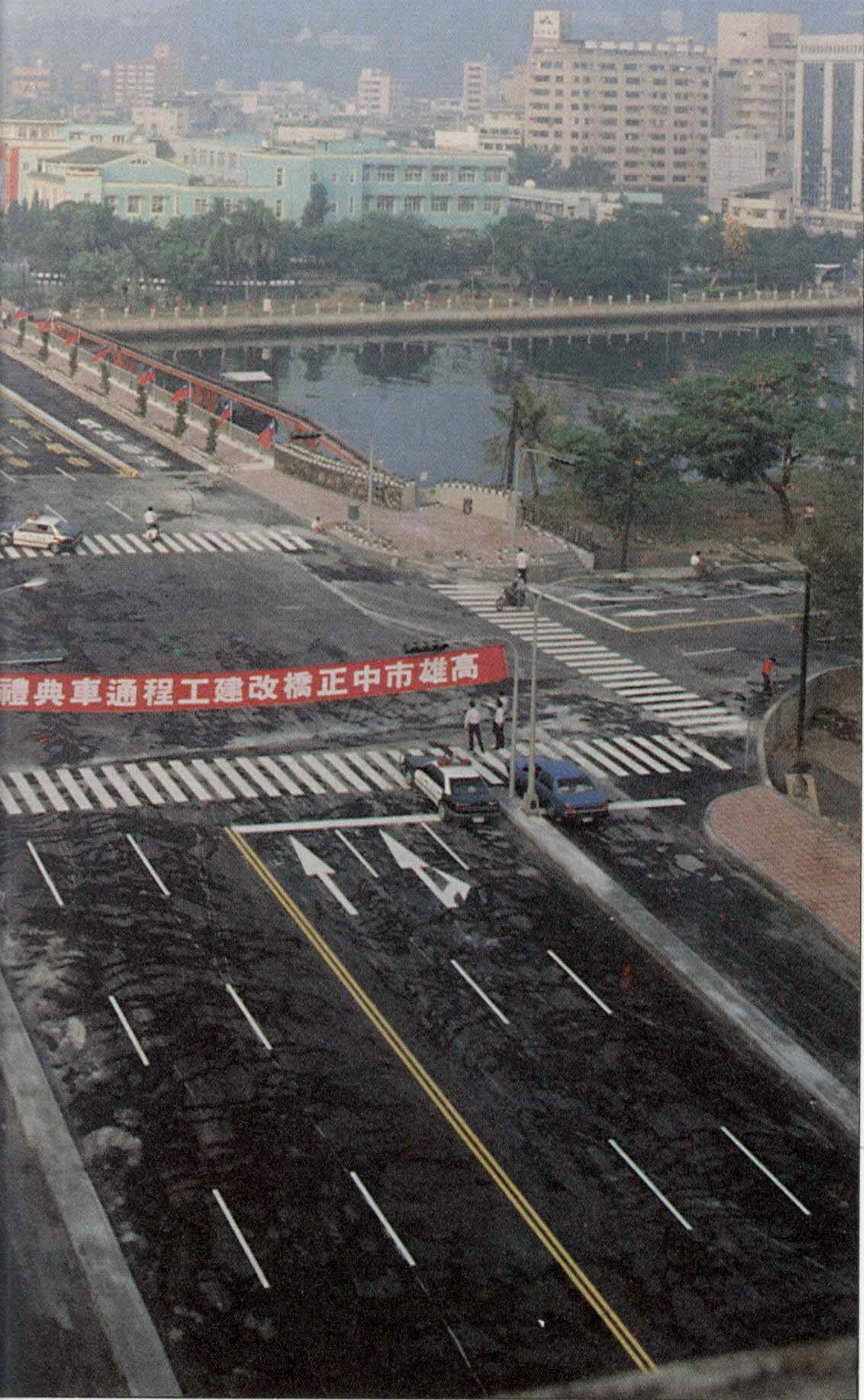
改建後的中正橋，橋面更寬、更長、交通更便捷
