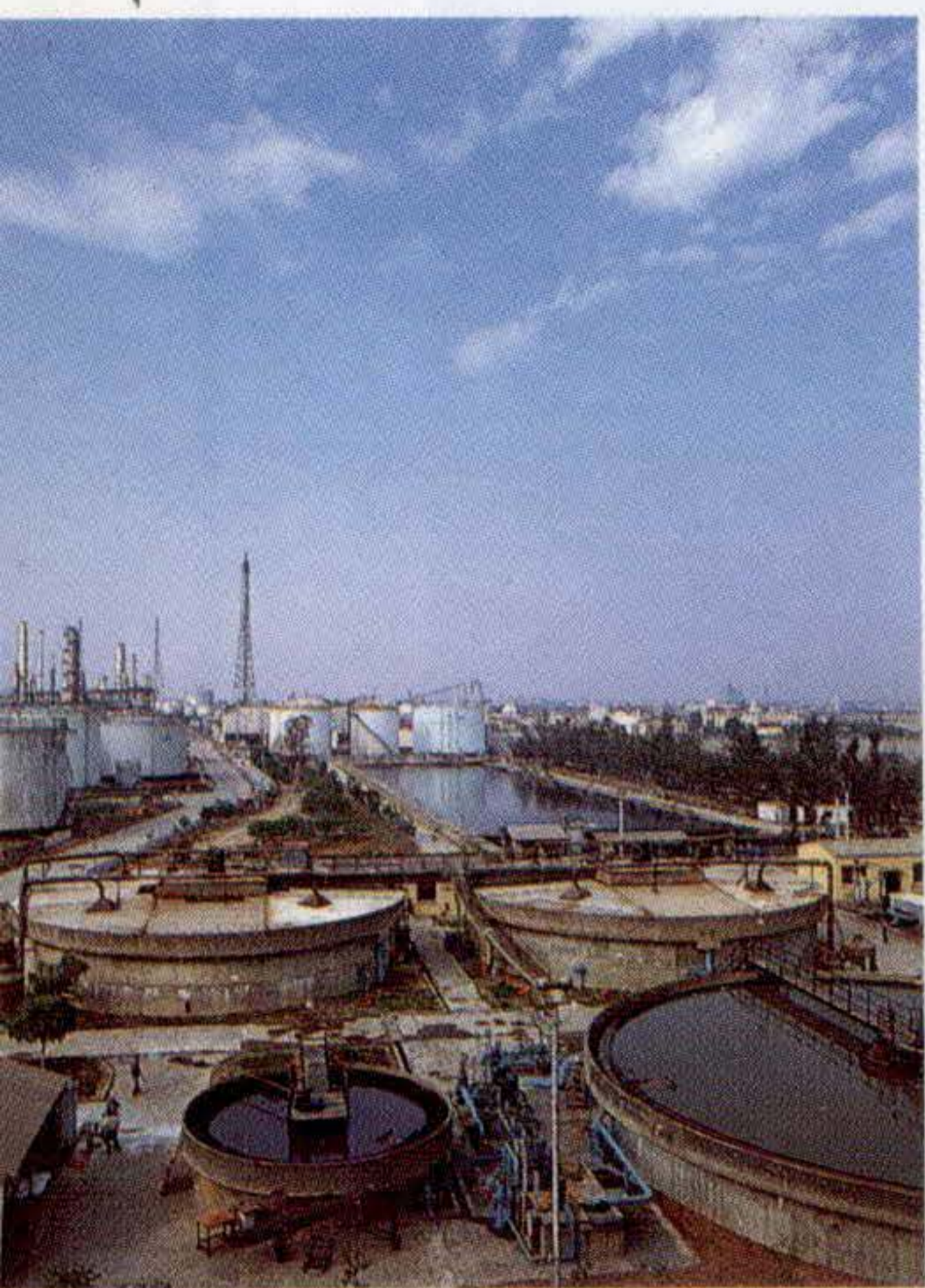
廢水處理場改成密閉式以防產生臭味
