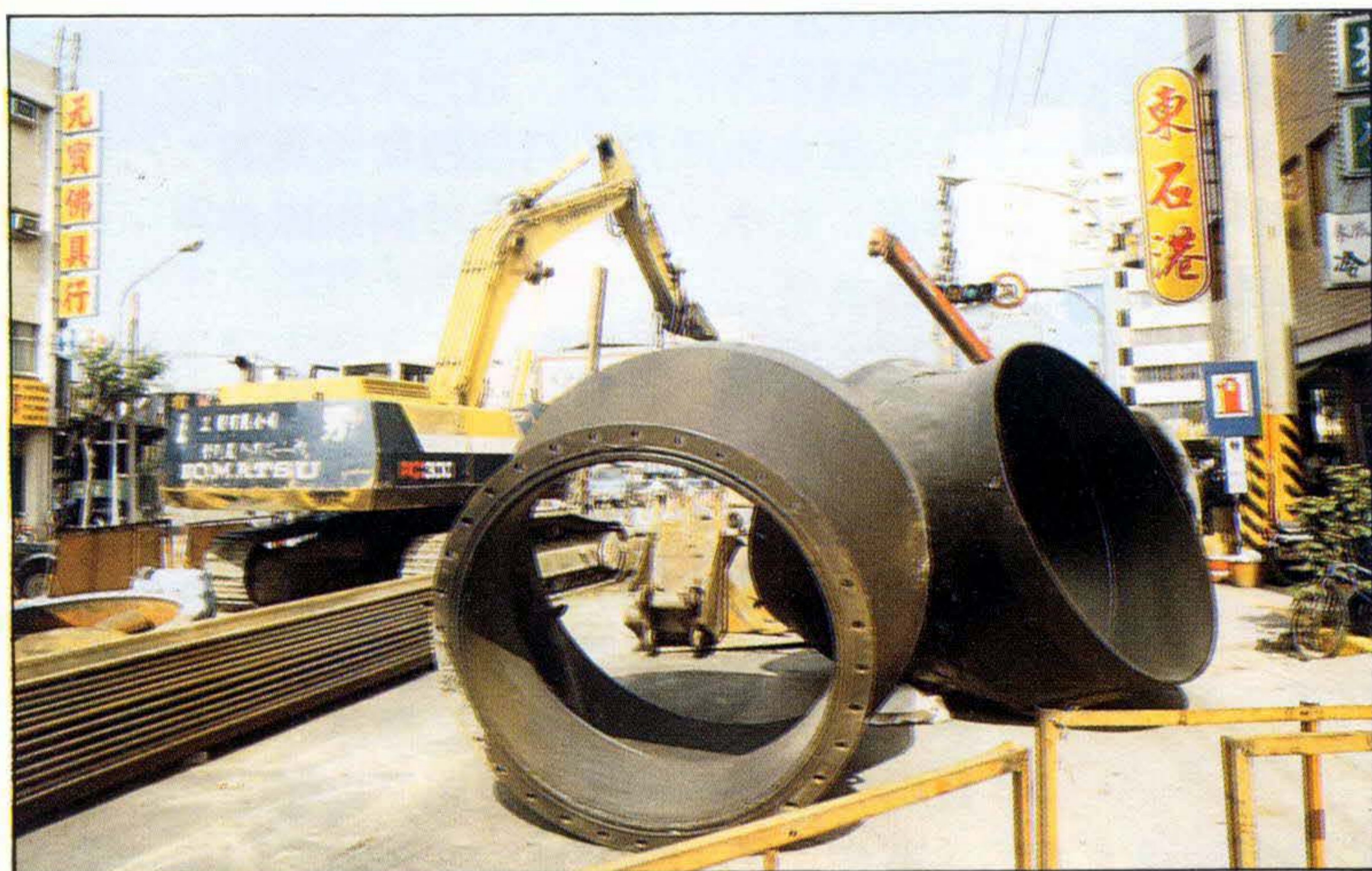
汰換老舊水管工程，預計八十一年六月底以前可以完工
