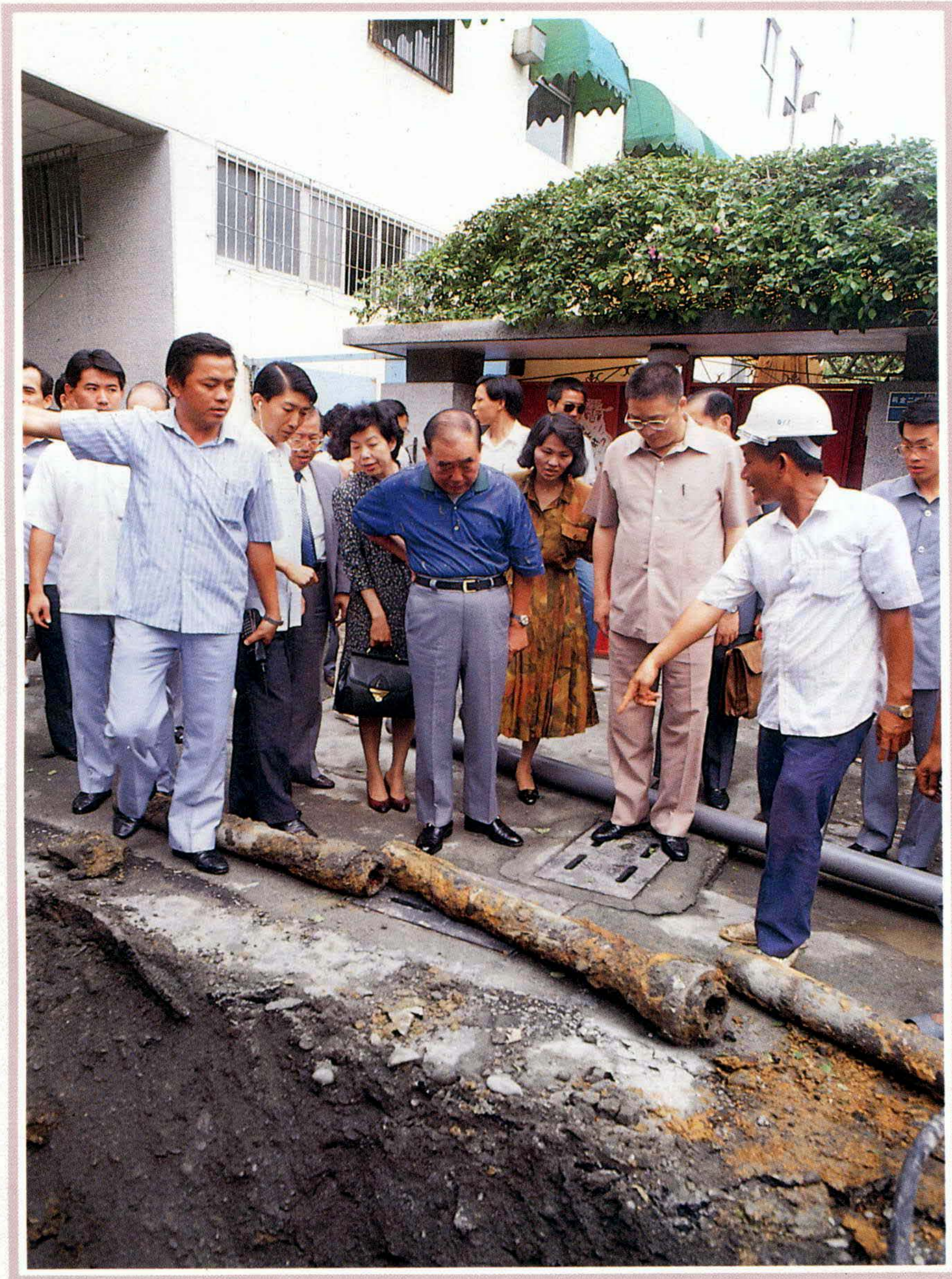
郝院長一行由吳敦義市長陪同 前往金二街了解老舊水管汰換工程
