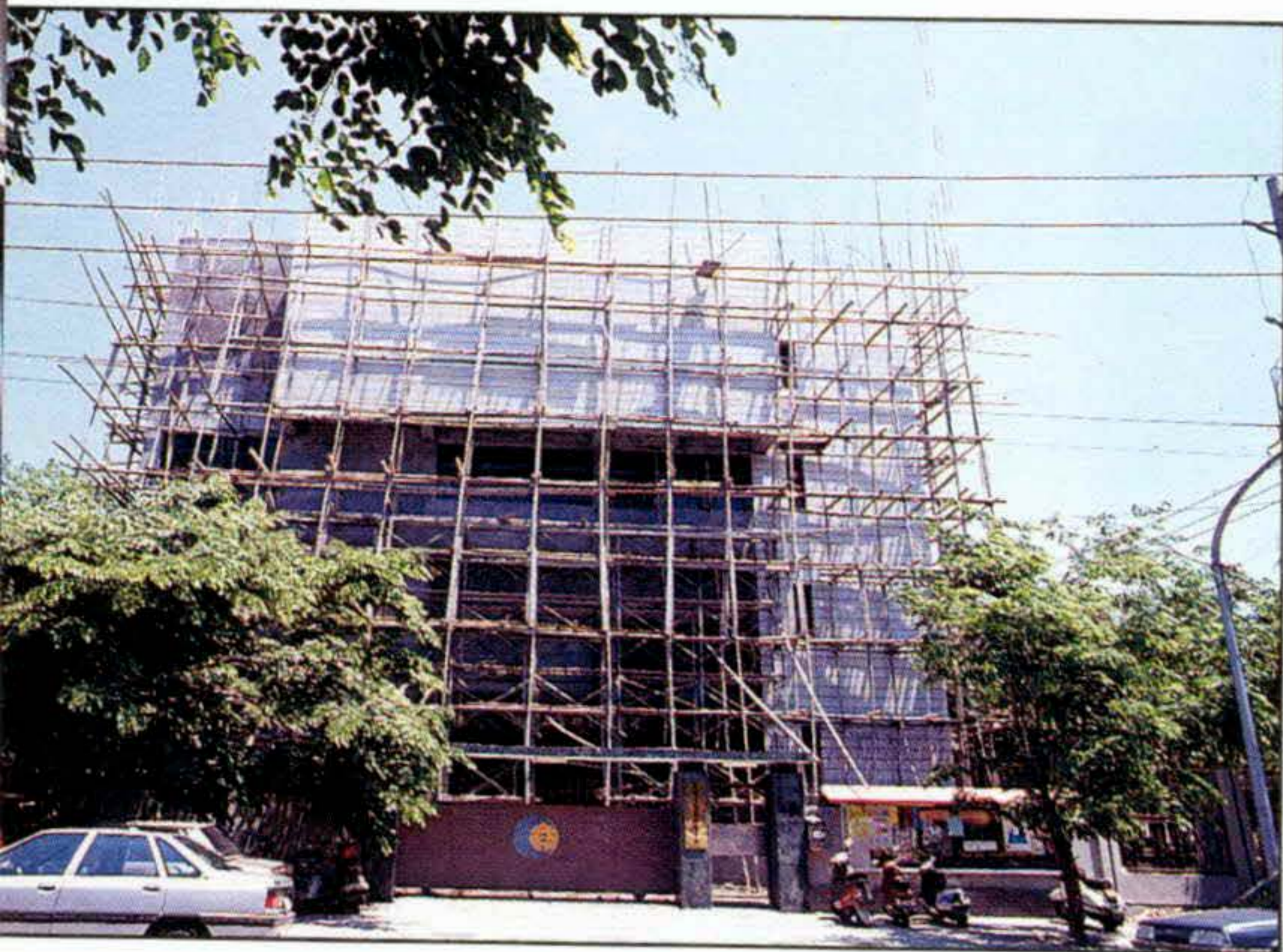
整修中的市政電台。
