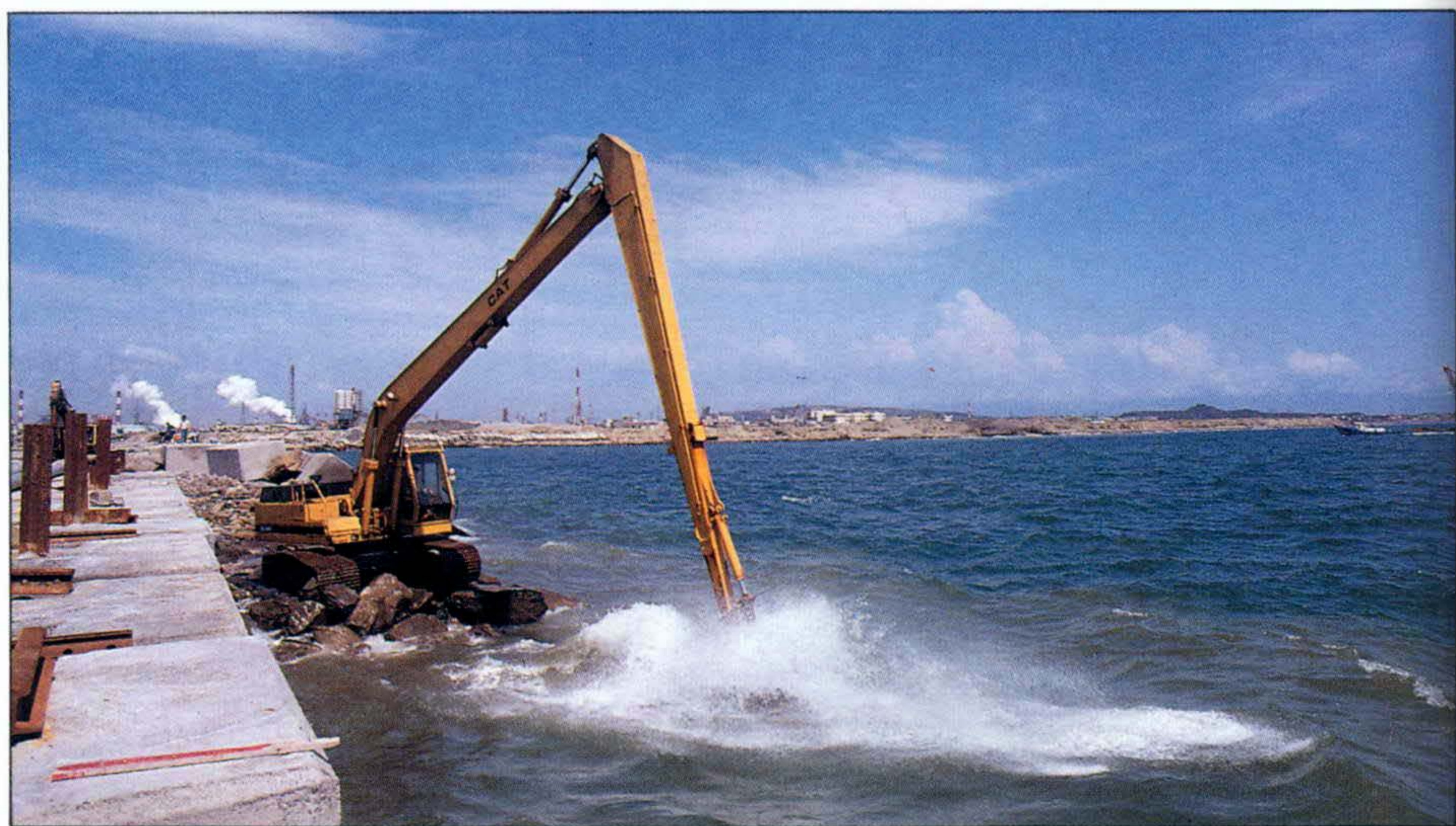
南星計畫第一期海堤工程。
