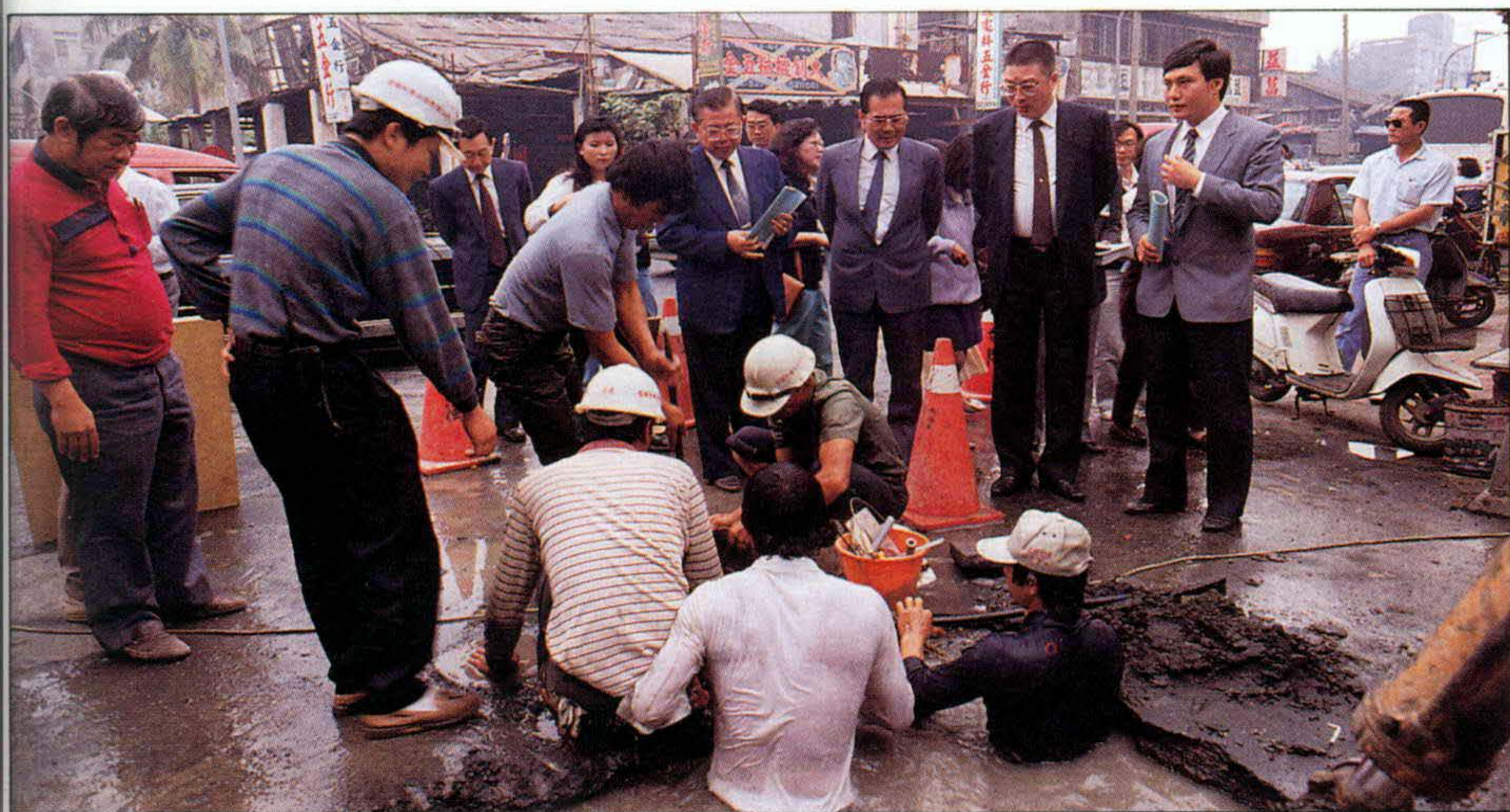
汰換自來水老舊水管。
