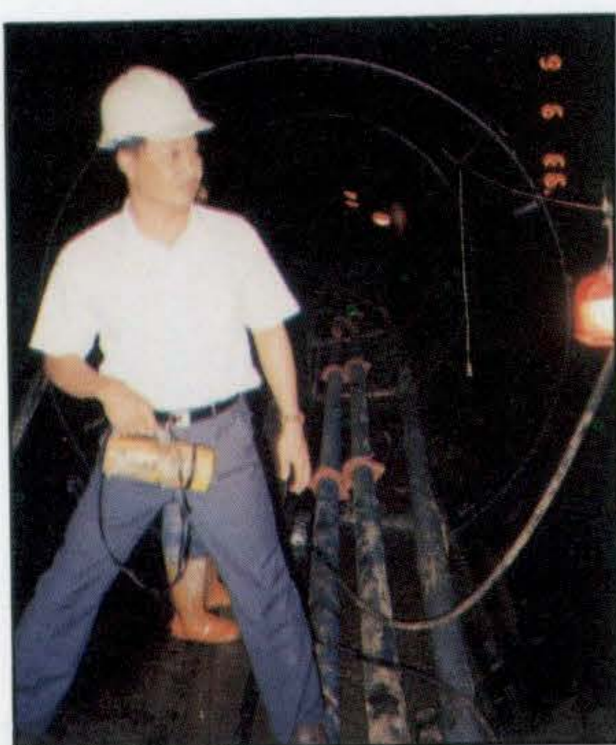
◁南化水庫豐德至茄拔林段幹管工程採半潛遁施工方法，勘查人員必須深入地下的導水隧道一一察看。
