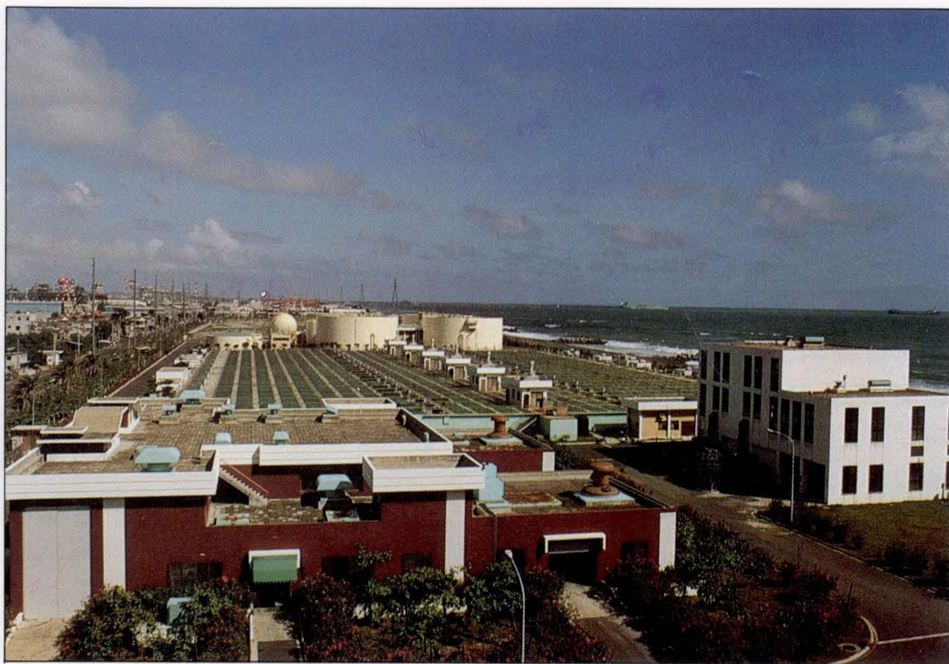
△中區污水處理處一景。
