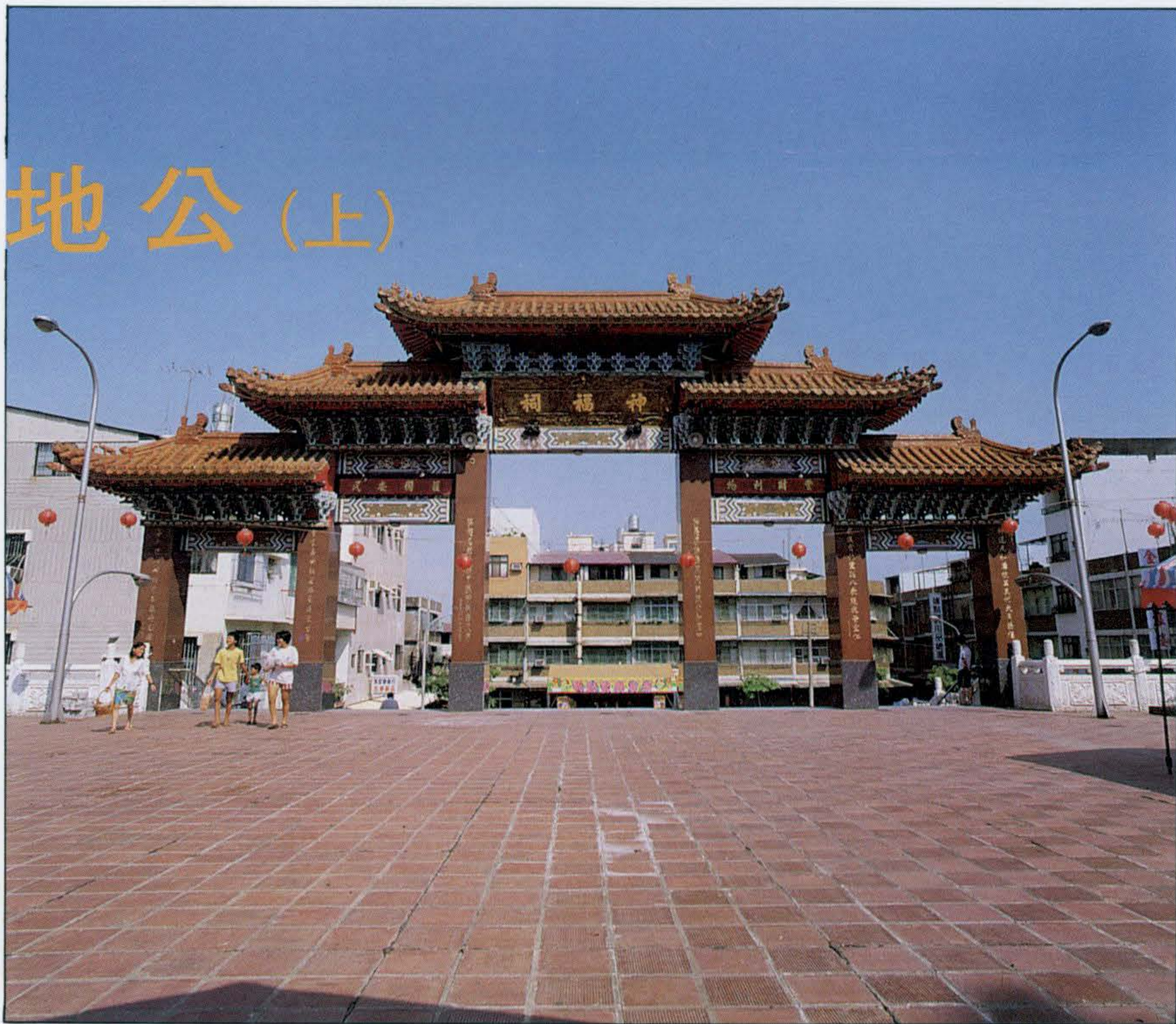
△內惟鎮安宮巍峩的大門。
