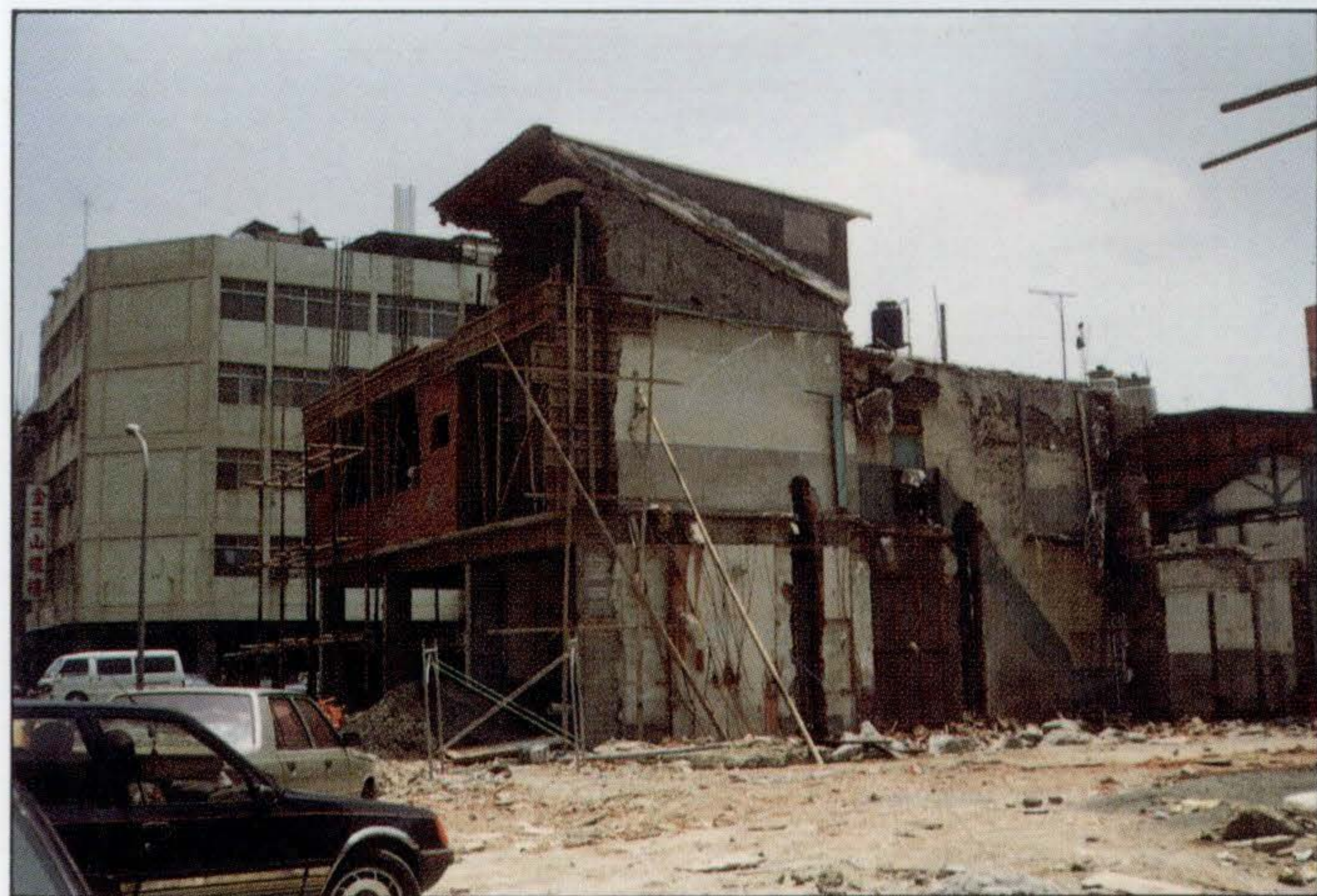
▽老屋拆除後整建中的「殘缺」景象。
