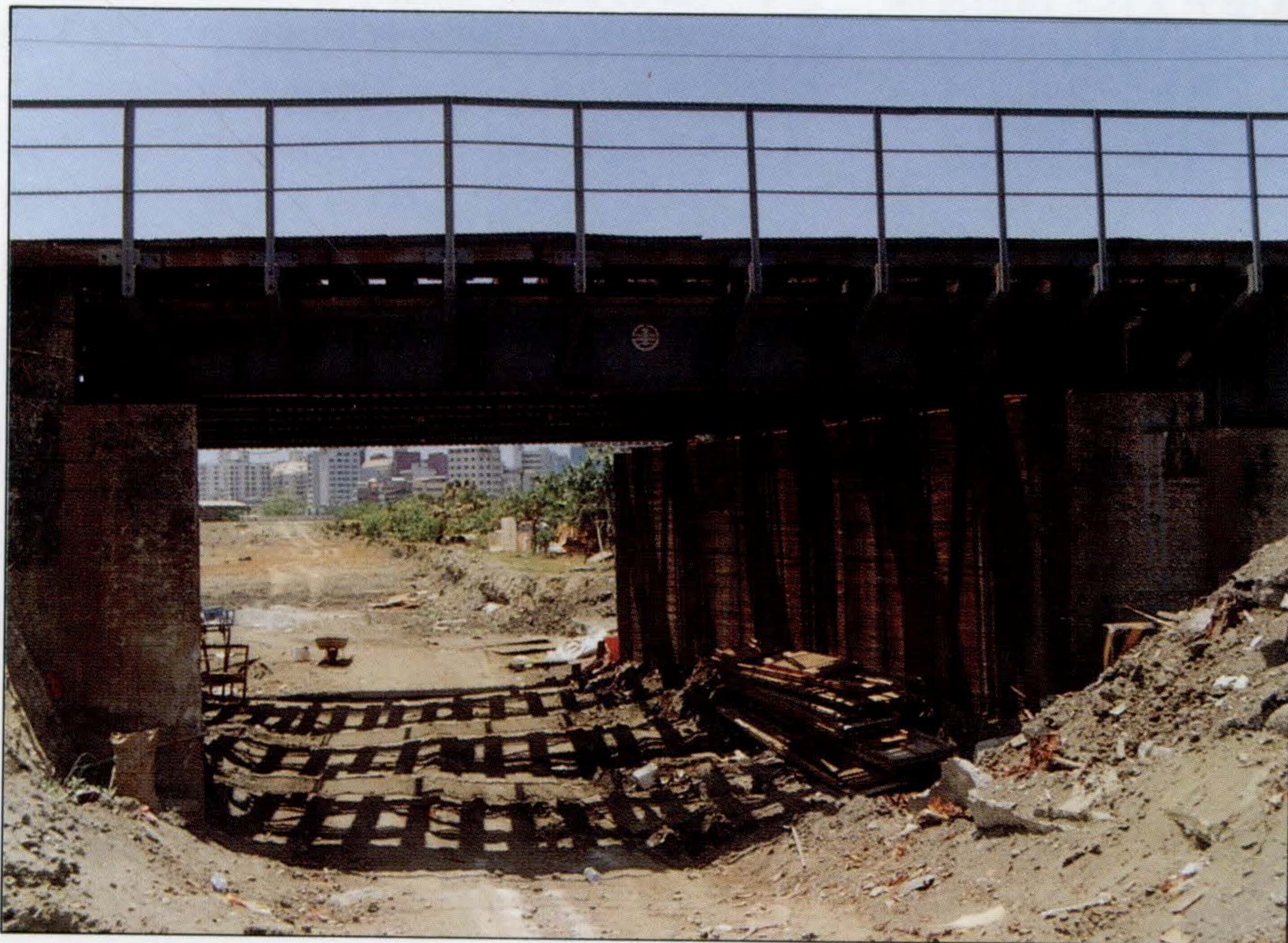
△同盟路立體交叉工程目前施工情形。(史德修攝)
