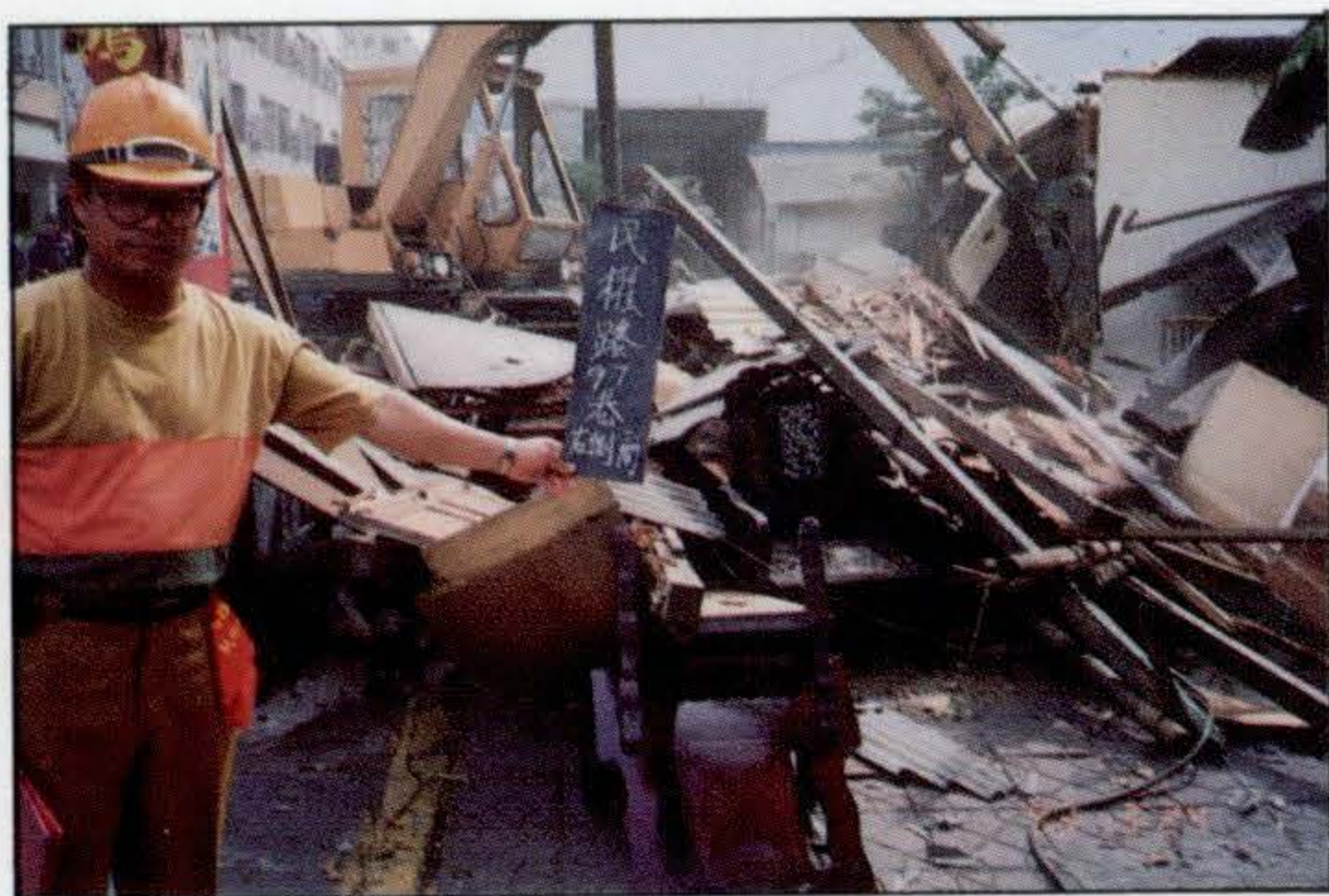
◁ 拆除民權路九十七巷違建戶。
