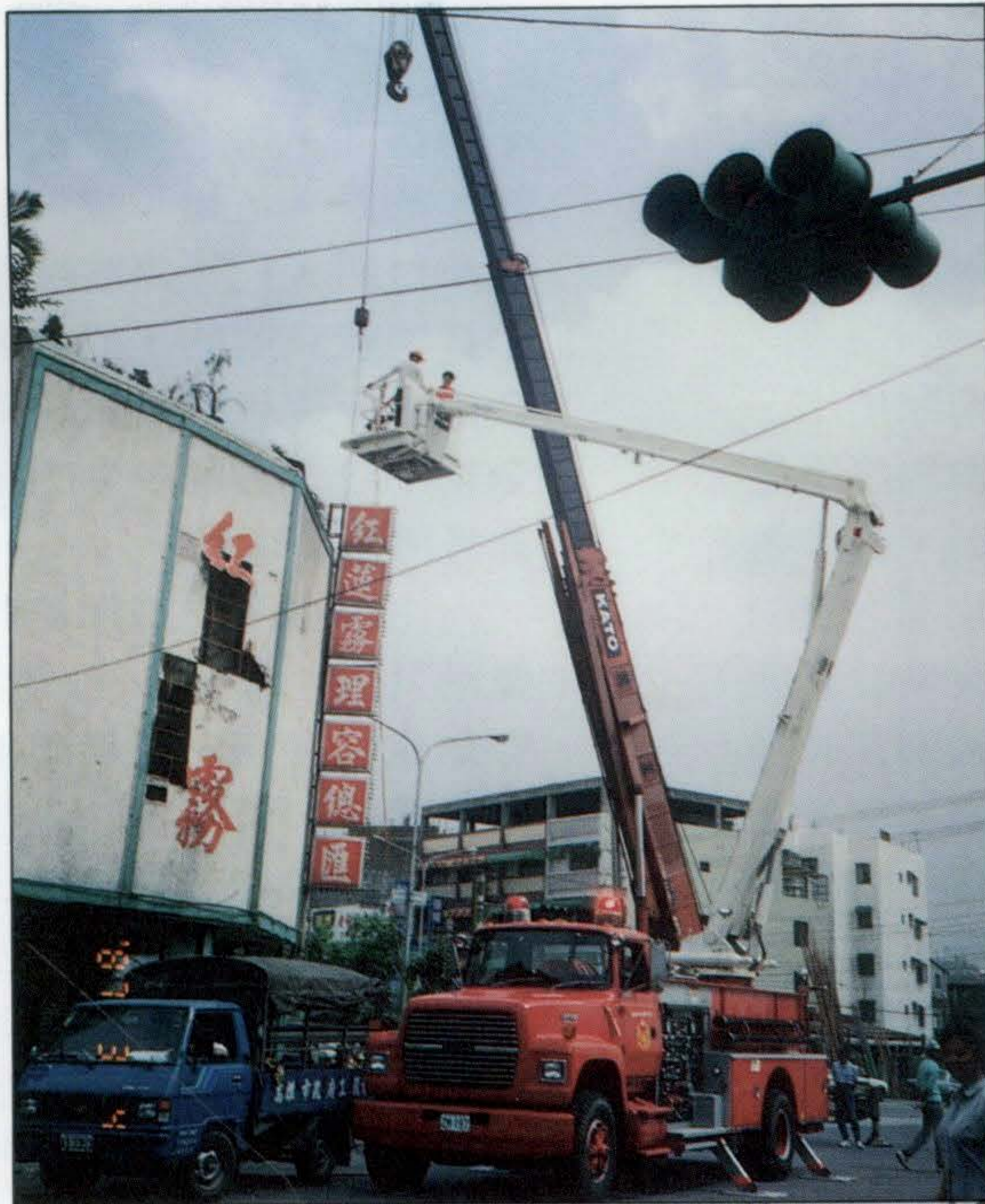
△拆除違規廣告招牌。
