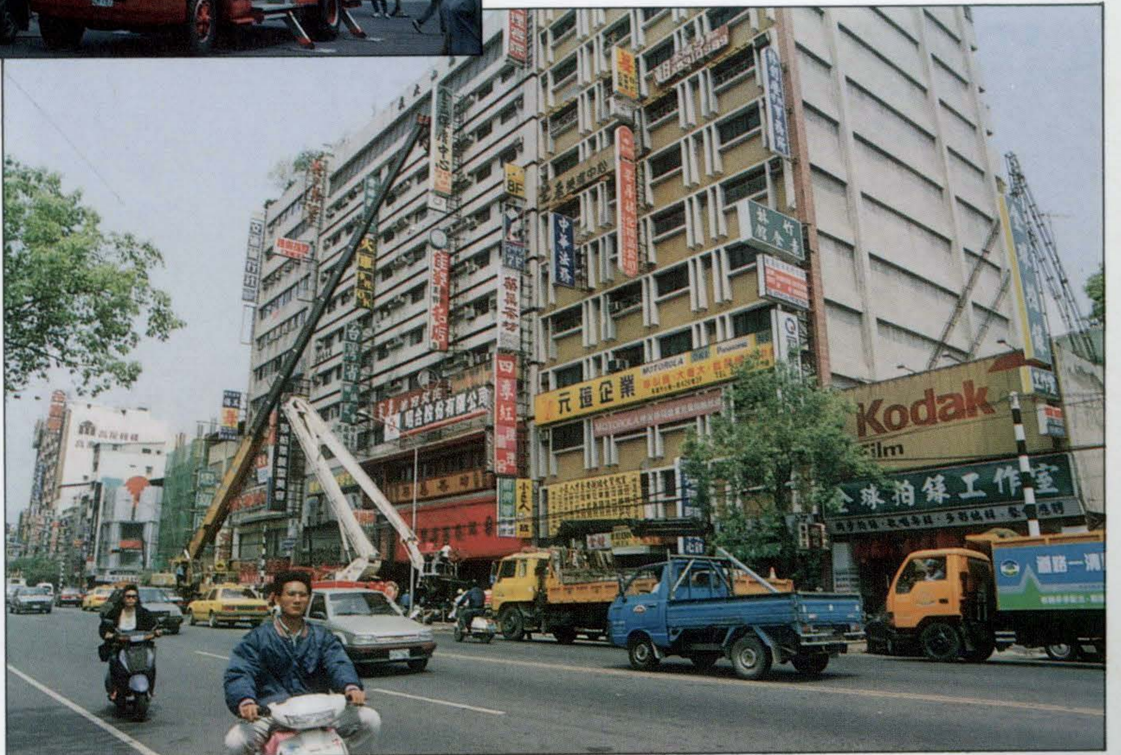
△拆除七賢一路違規廣告招牌。
