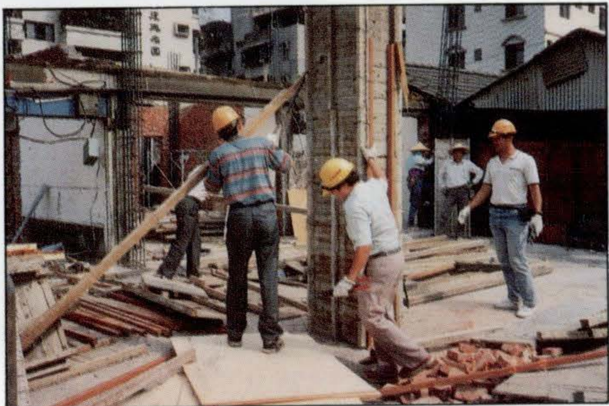
▷ 拆除民權路違建戶。
