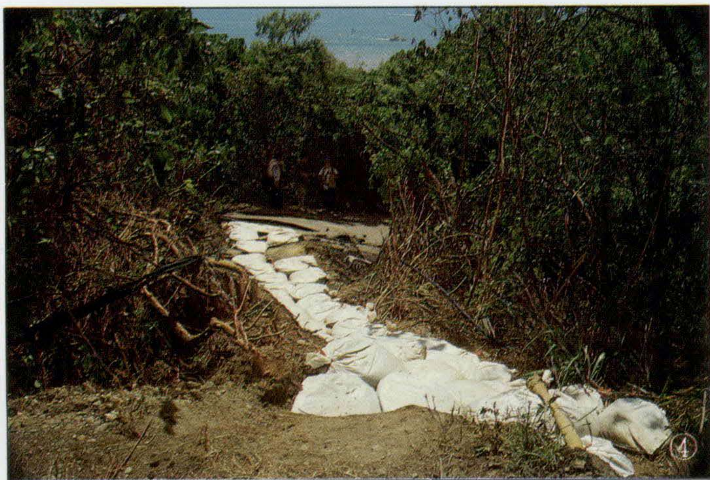
△柴山戰備道路崩塌現場。(黃東生攝)
