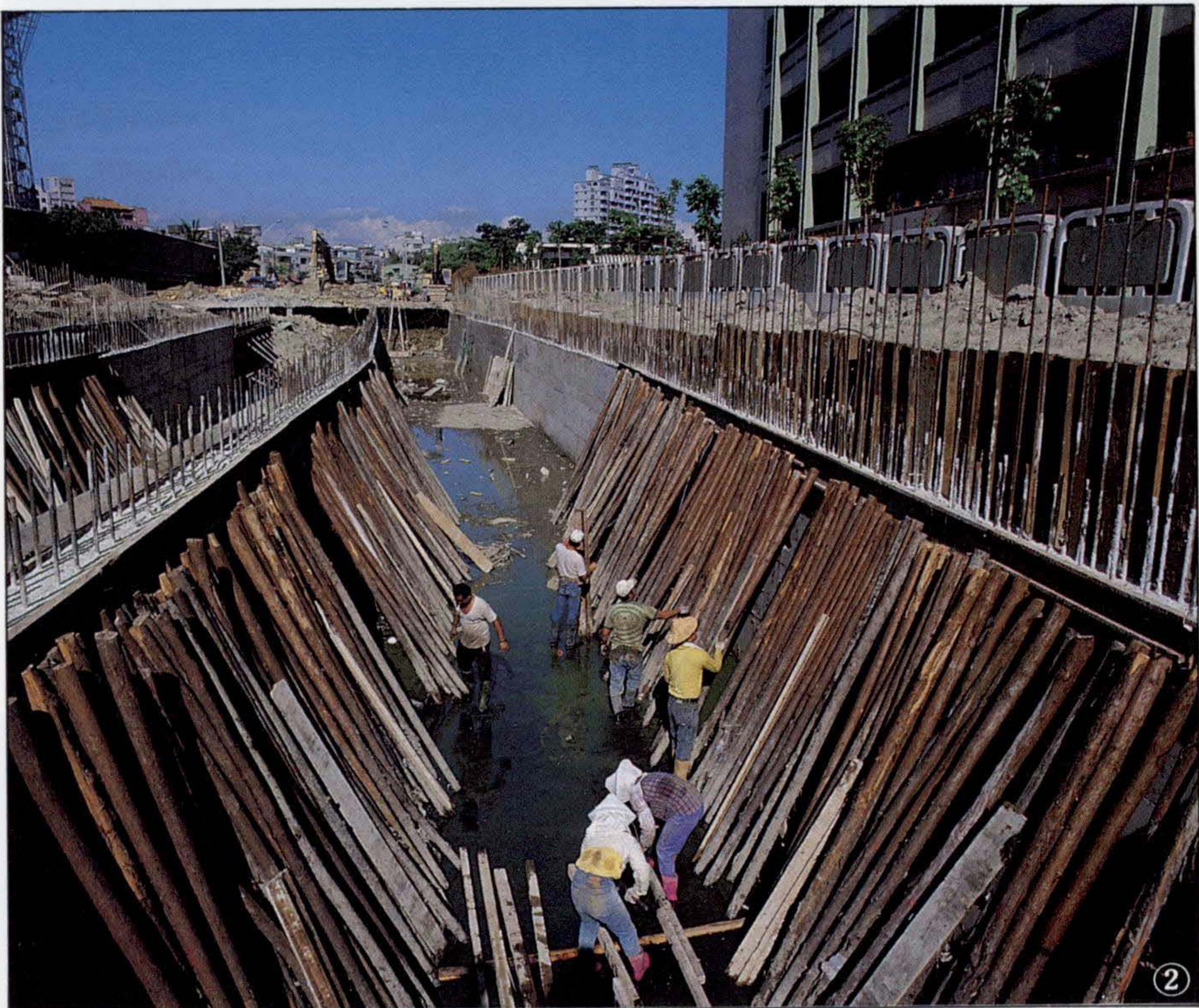
①②寶珠溝排水溝工程施工情形。(黃東生攝)
