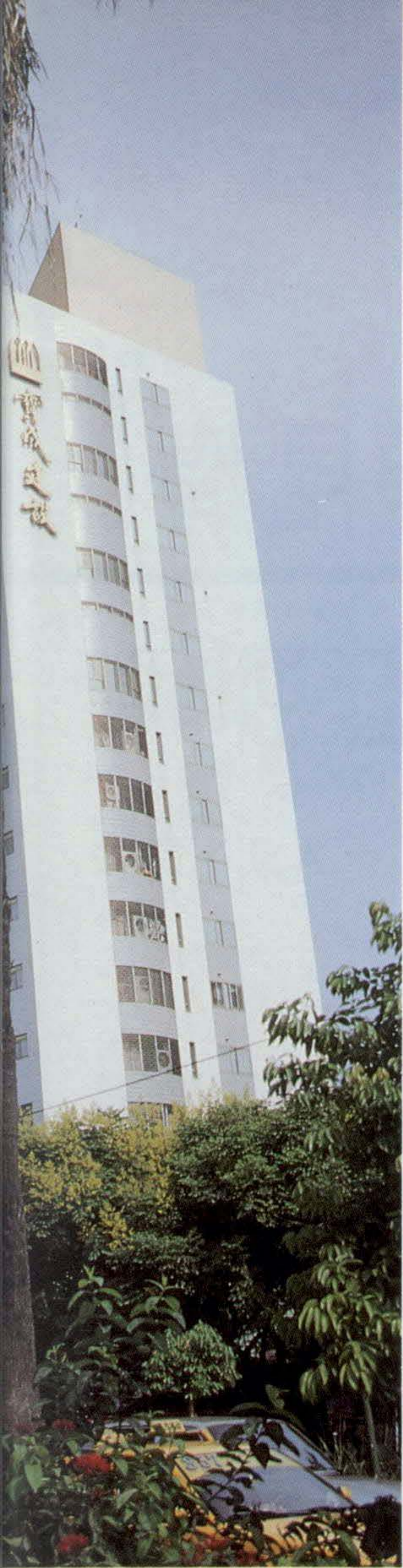
◀民生二路上乳白色西式建築
