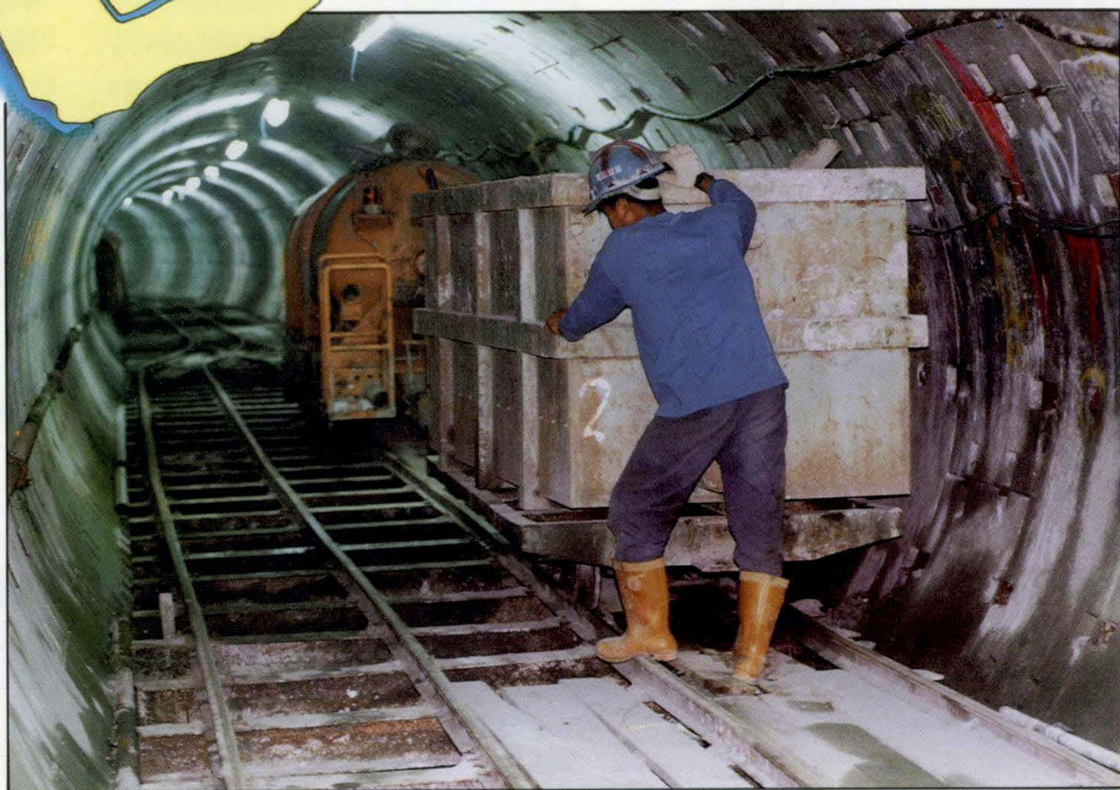
施工中的污水下水道。(何得福攝)
