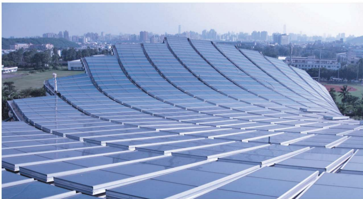
主場館的屋頂由8,844片太陽能光電板結構而成，年發電量達114萬度。
