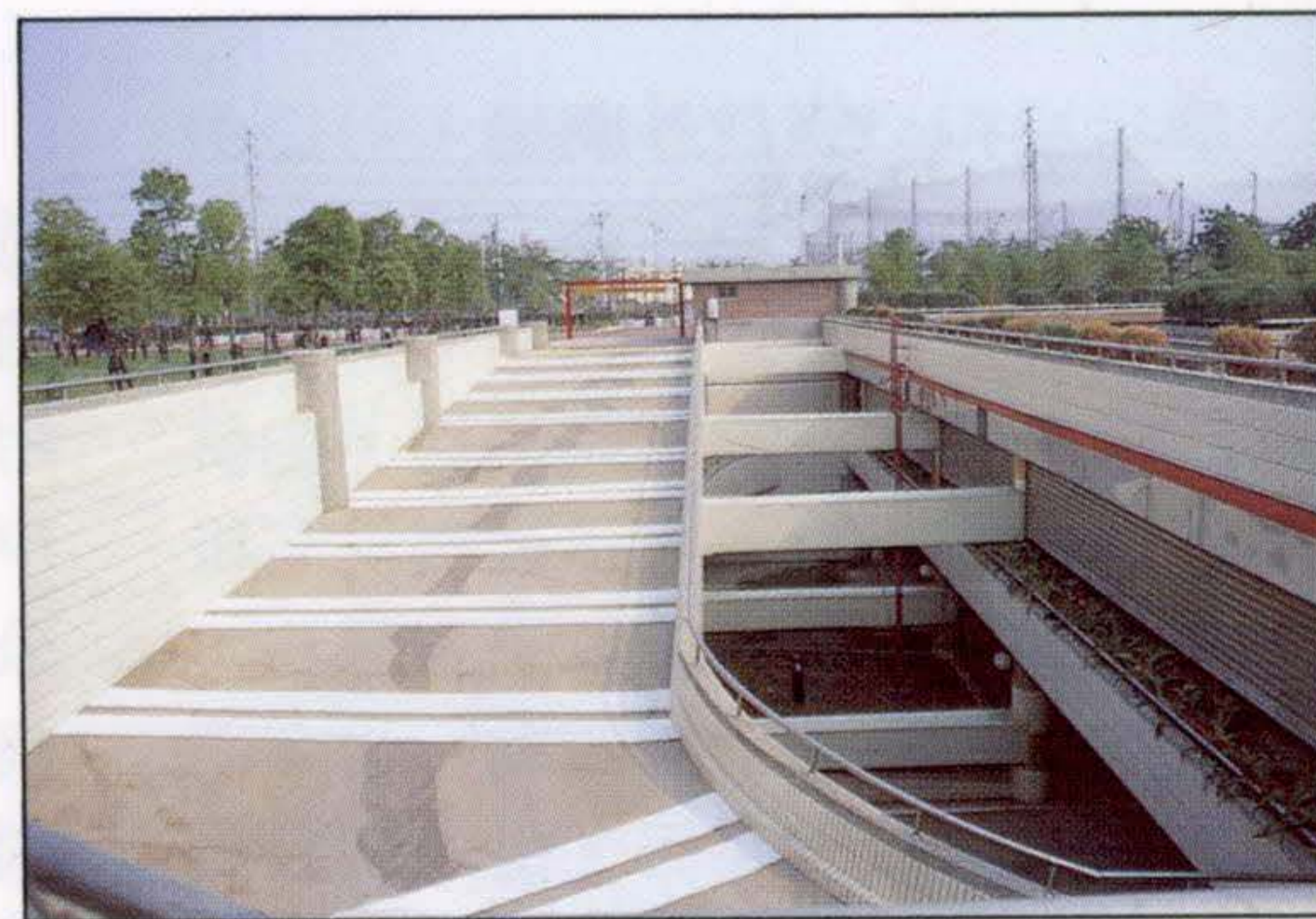
都會公園的地下停車場。
