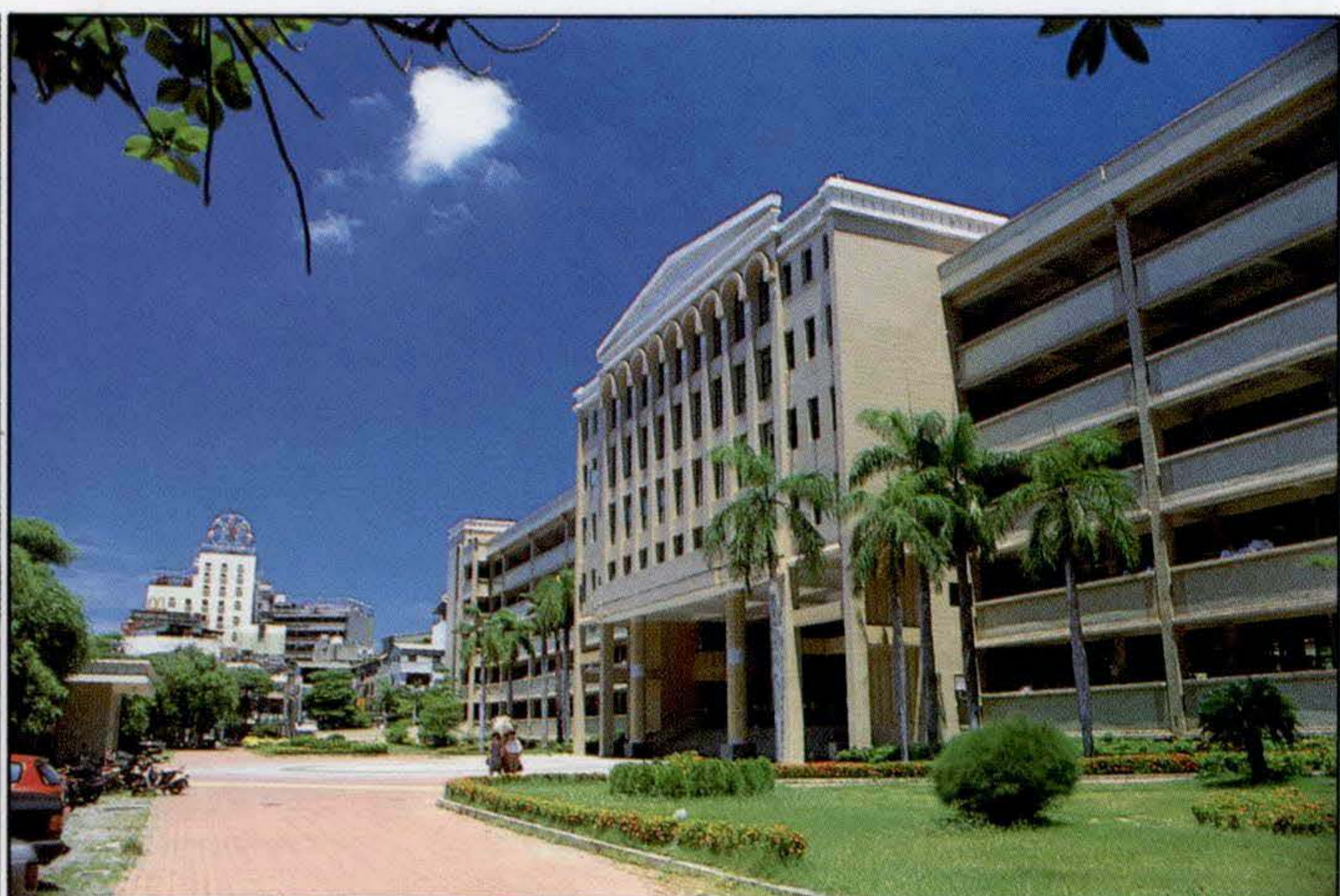
新興國中第一棟新建的大樓巍峨壯觀。
