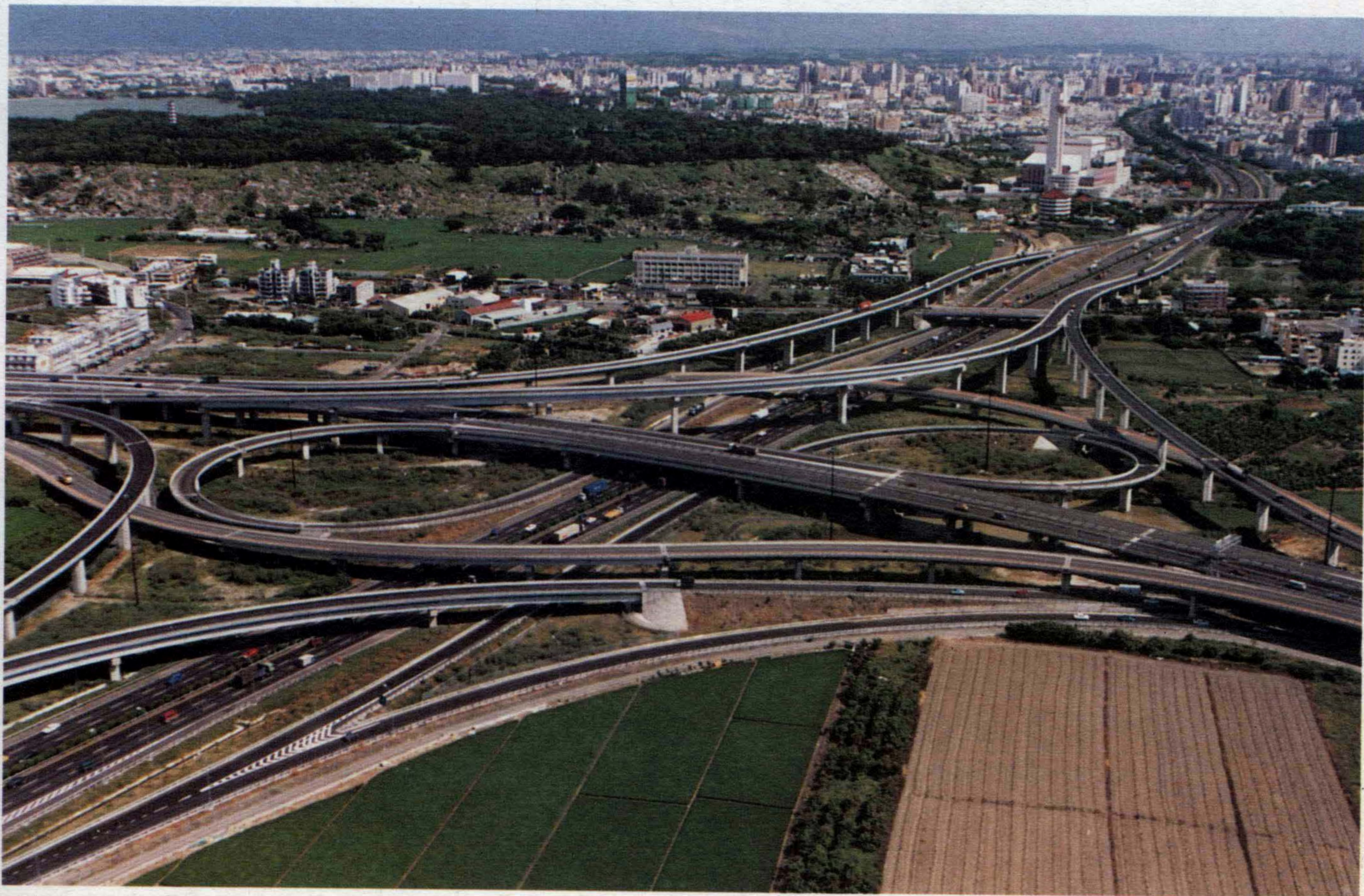
▲高速公路鼎金系統交流道主體工程於八十六年十二月完工，未來連接快速道路系統，成為港都交通新動脈。
