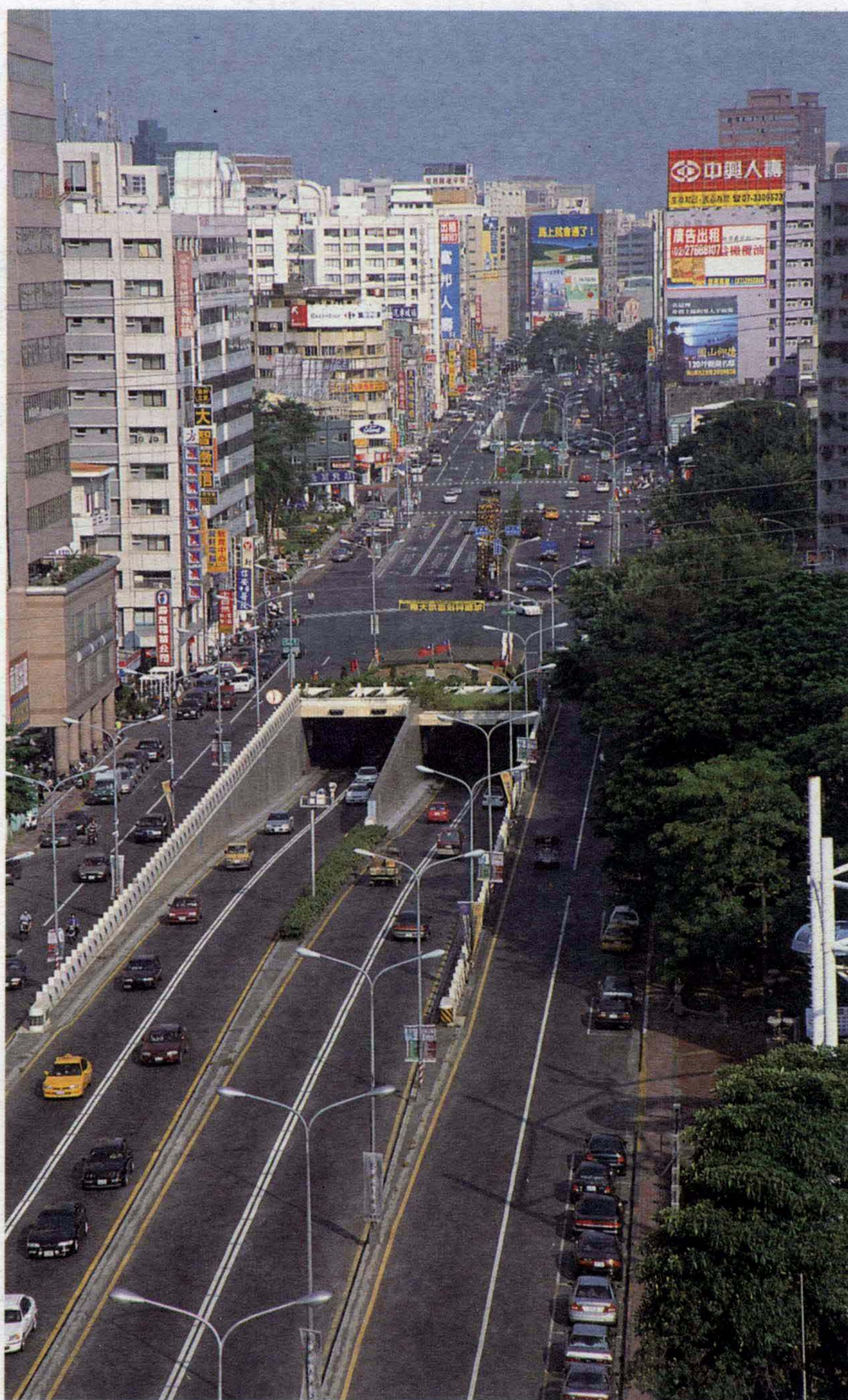
▲中正凱旋路立體交叉工程通車後，疏解當地擁擠的交通。
