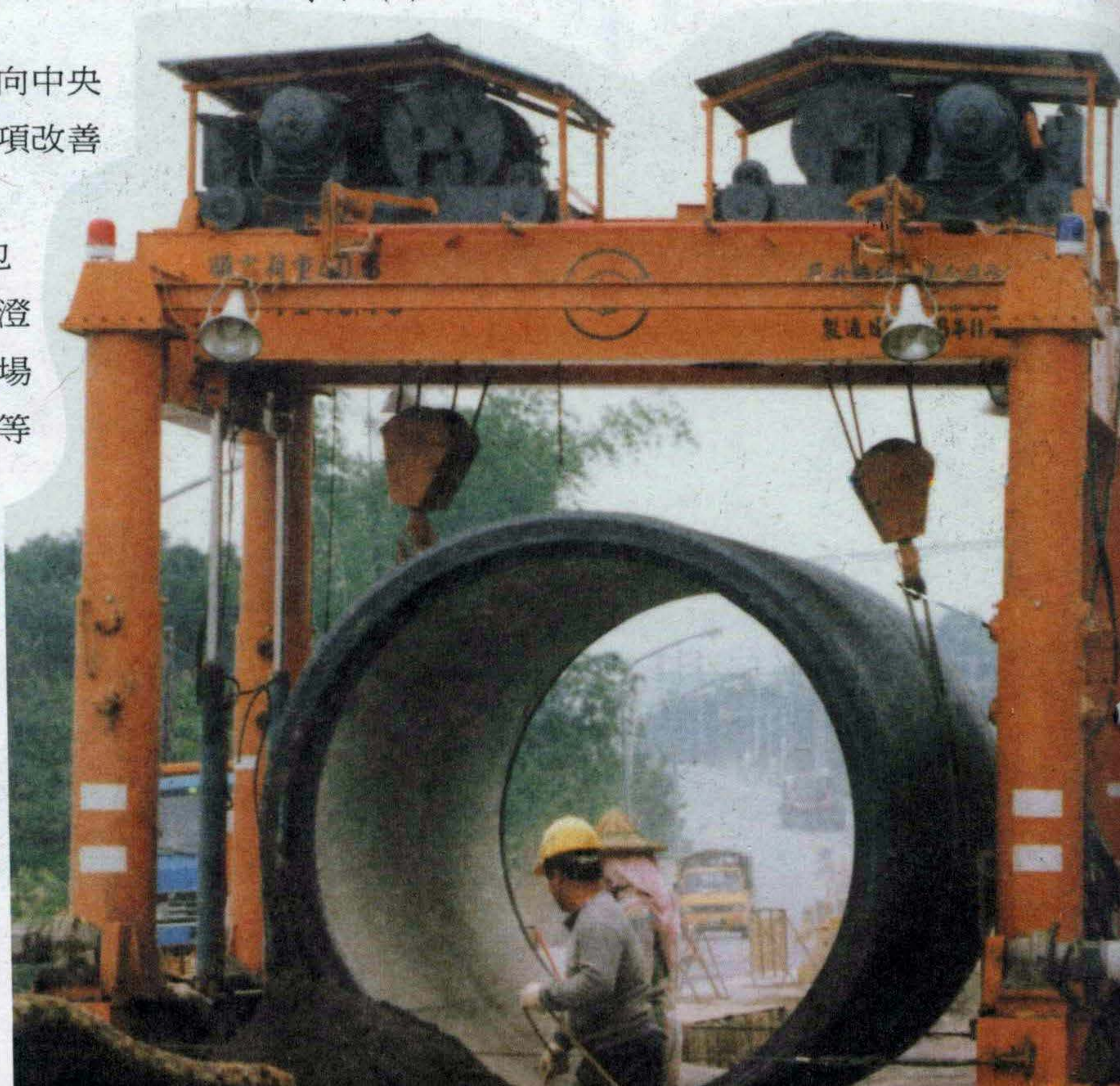
▼自來水公司於高屏溪攔河堰埋設 3200m/m 專用導水幹管。
