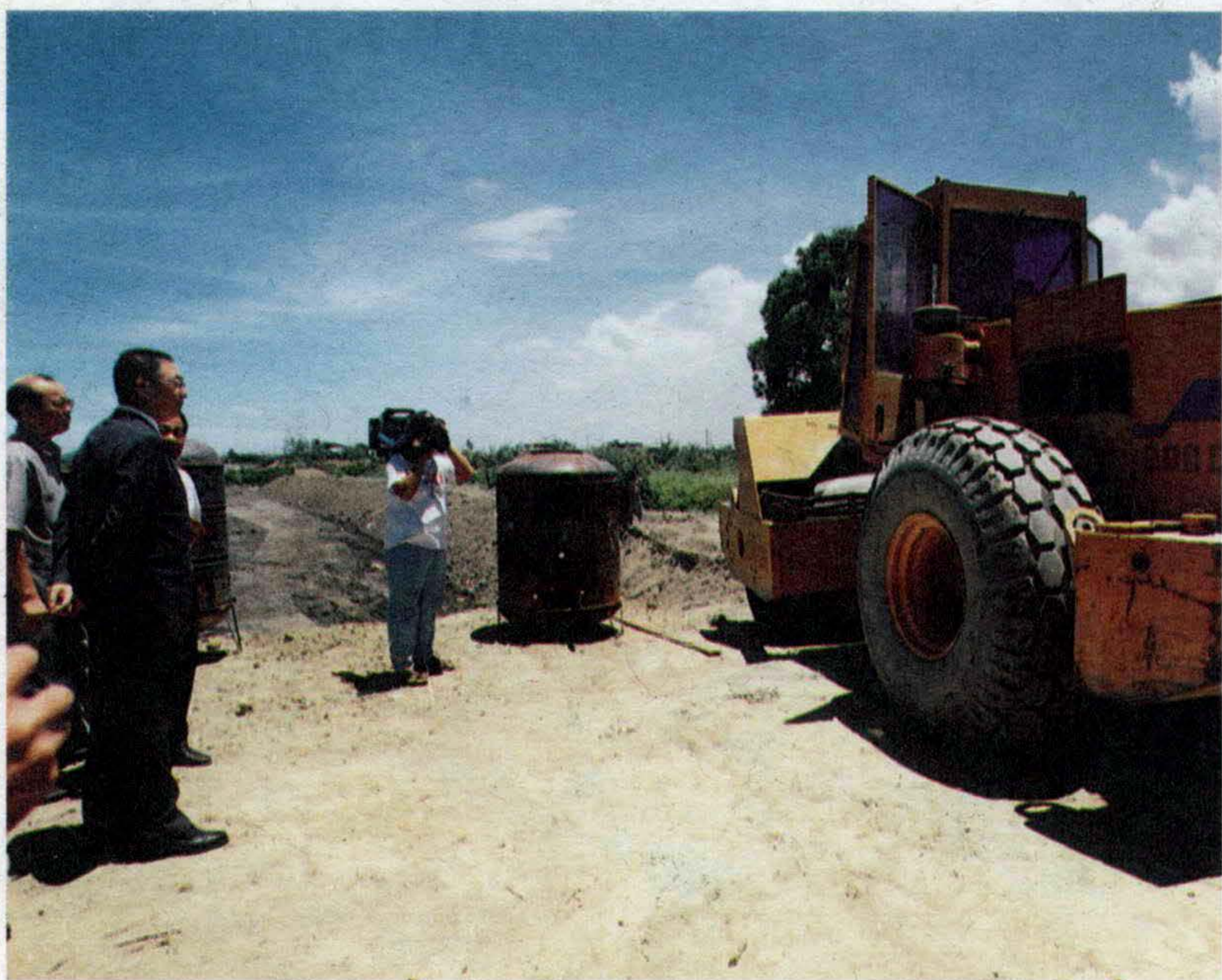
▲吳市長巡視高雄大學校舍建築基地整地工程。
