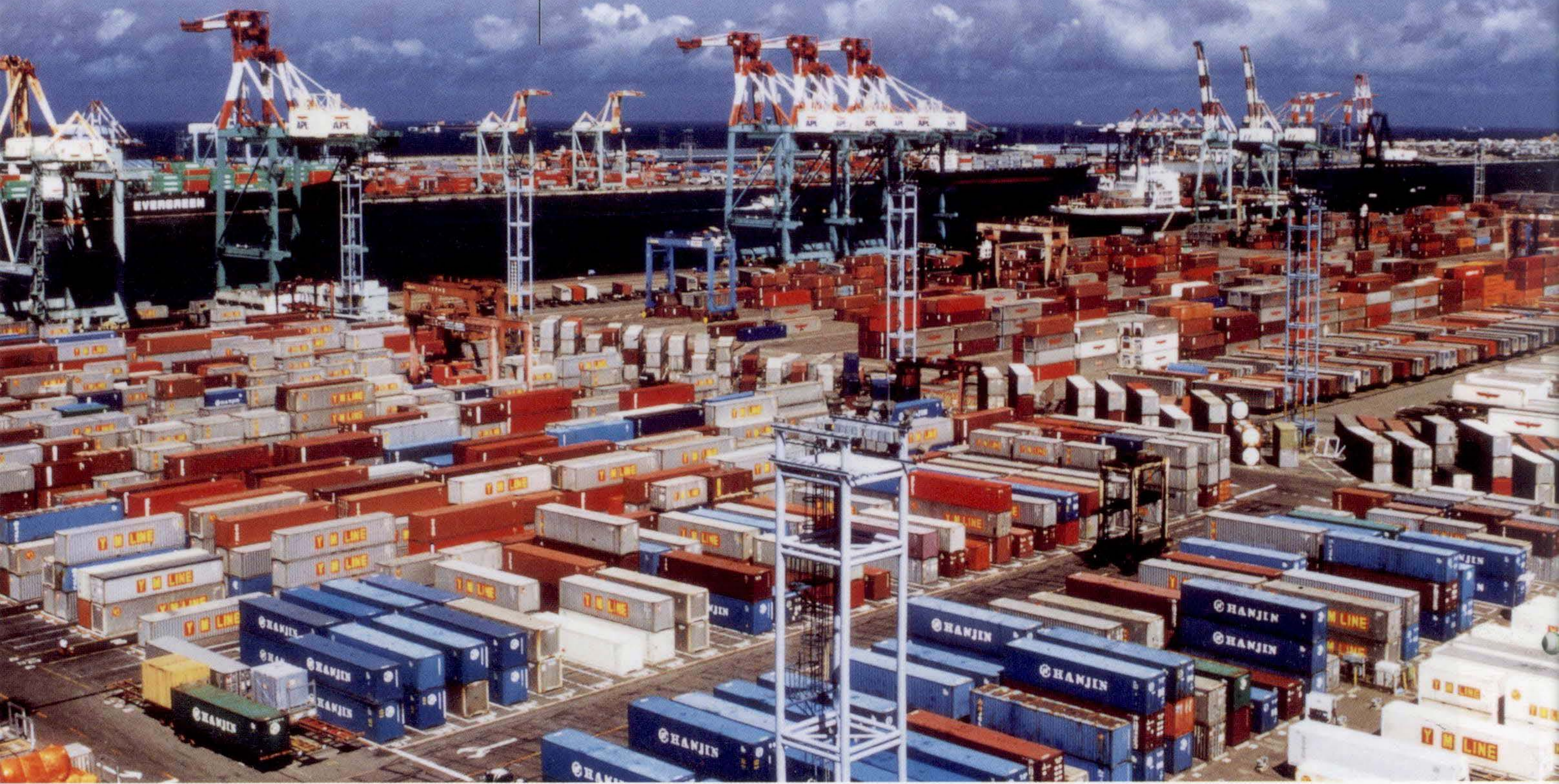
▲倉儲轉運專區結合高雄港貨櫃轉運及加工出口區倉儲轉運兩大功能，大大提昇產業的附加價值。（郭吉清／攝）
