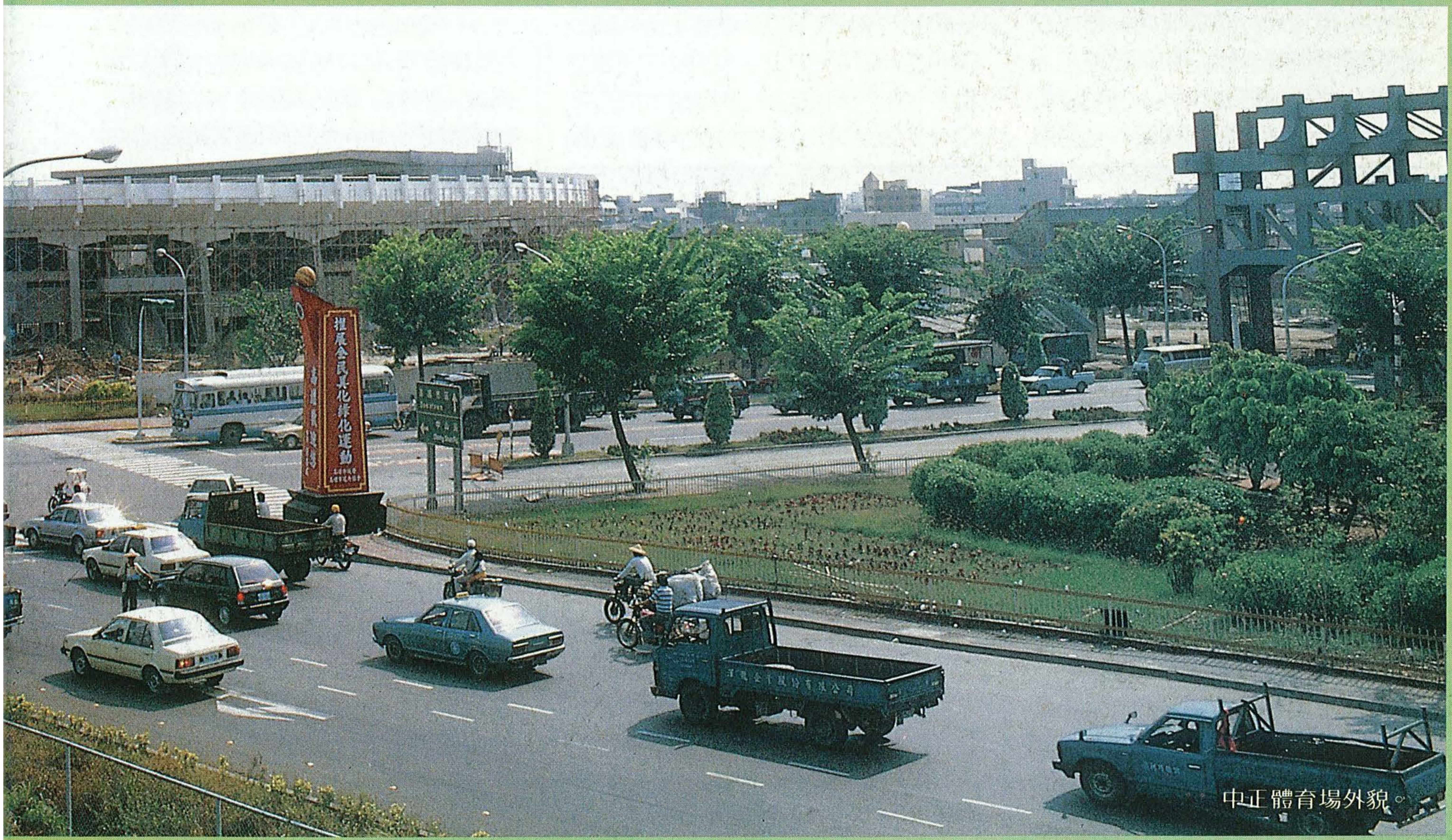
中正技擊館外貌。
