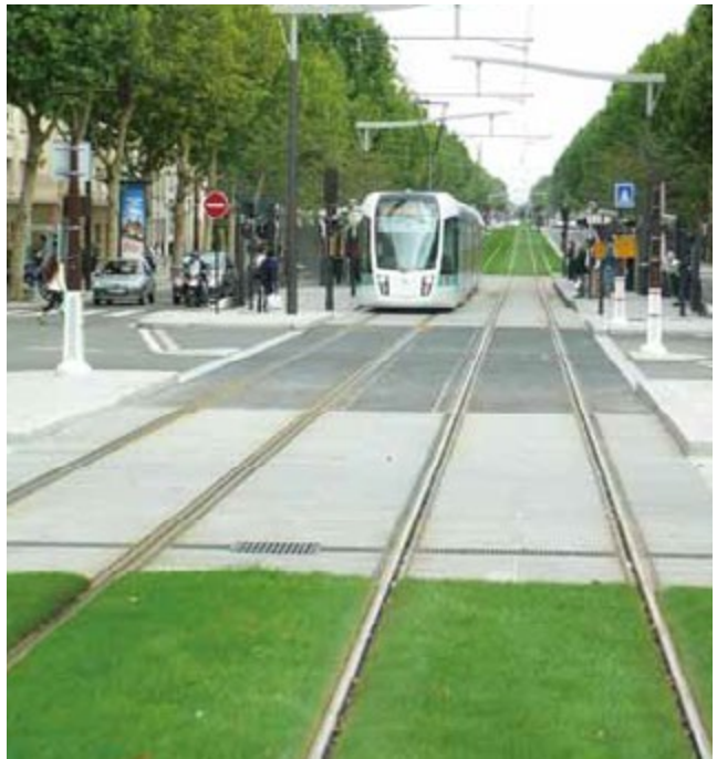
■ 高雄輕軌未來將如他國輕軌鋪上透水草地，擁有高綠覆率
