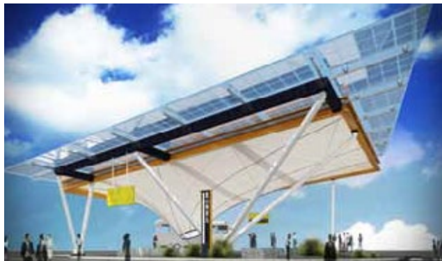
■ 鳳山轉運站即將完工
