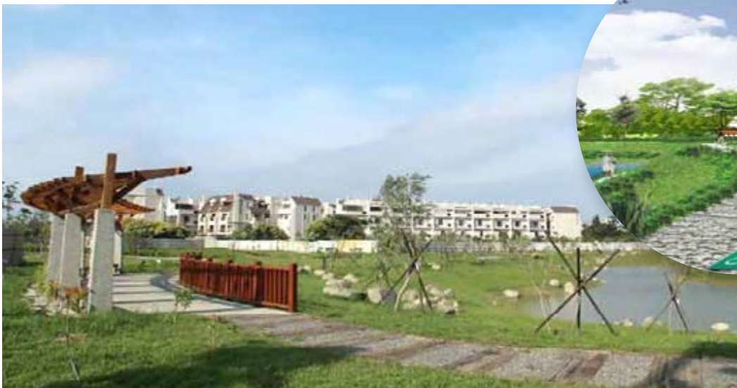
■ 仁武區獅龍溪滯洪池暴雨期時能發揮調節水位的功能
